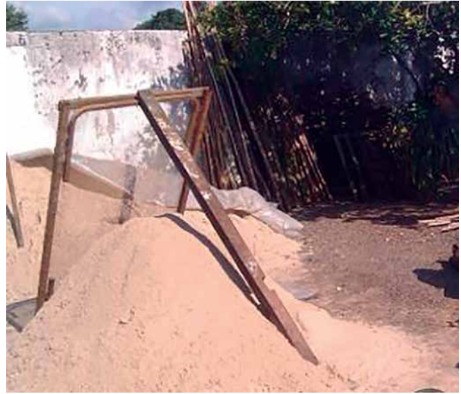
Foto 3. Arena lavada de río debidamente cernida.
