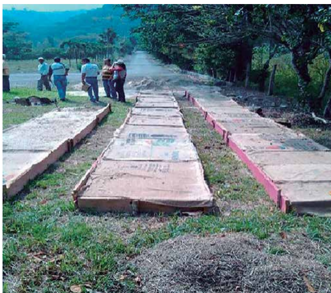
Foto 9. Cobertura con sacos de sisal.
