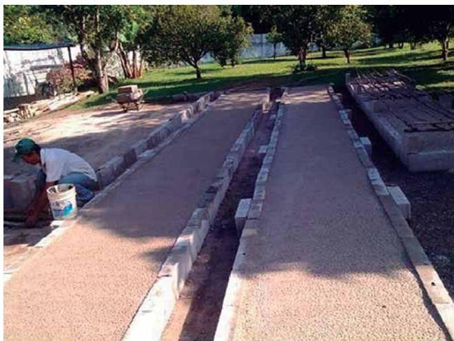
Foto 6. Nivelación de arena.
