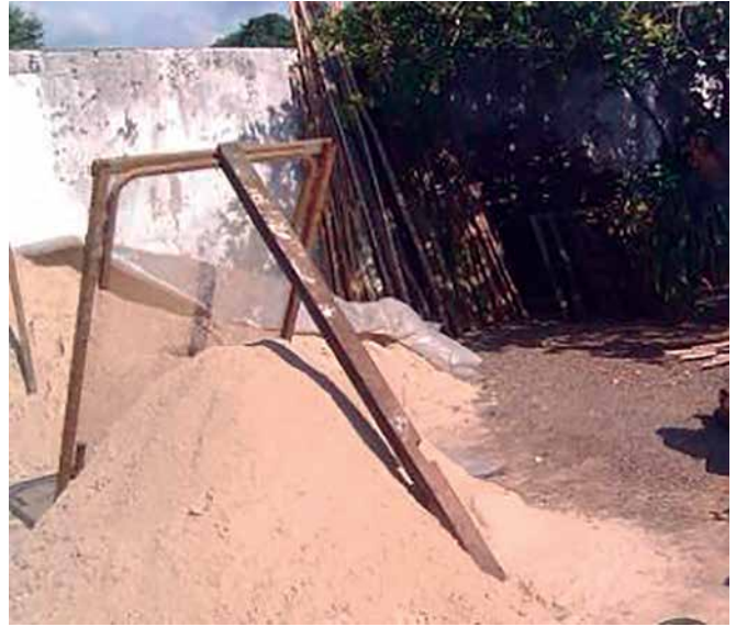
Foto 3. Arena lavada de río debidamente cernida.
