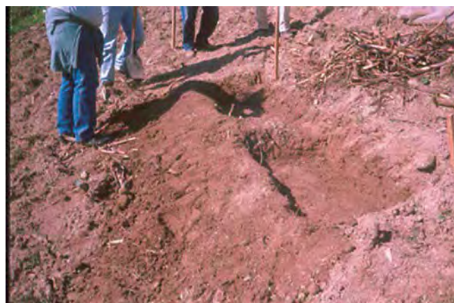
Foto 33. Zanjas de infiltración.
