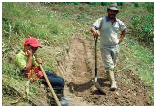
Foto 31. Construcción de la acequia con herramientas manuales.
