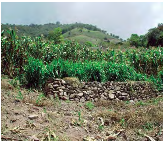
Foto 32. Muro de piedra.
