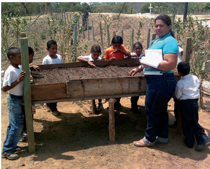
Foto 3. Construcción de barbacoa.
