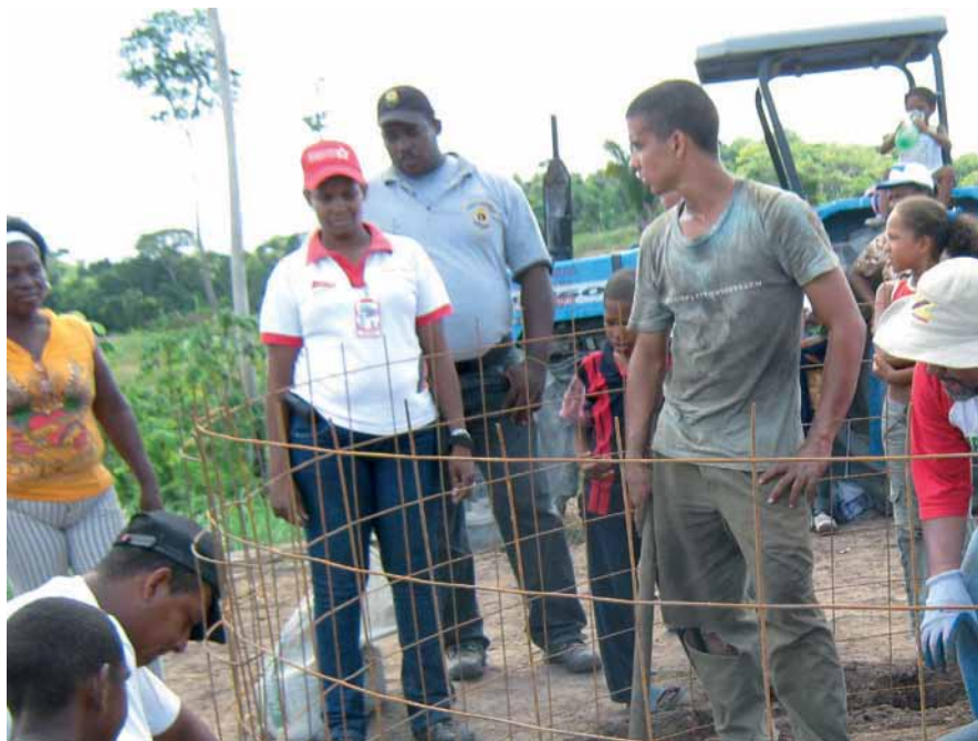
Foto 5. Apoyo desde la UNESR a la cooperativa TIANI en la construcción de un tanque australiano. Estado Miranda. 2009.
