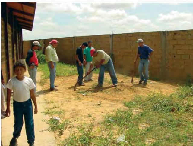
3. Abrir la zanja para enterrar la malla y la tubería de desagüe.
