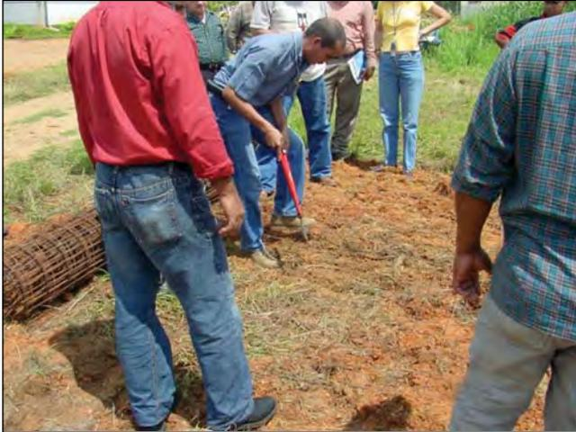
2. Limpiar y nivelar el área donde se construirá el tanque. Debe marcarse el círculo donde irá colocada la malla (3 metros de diámetro).
