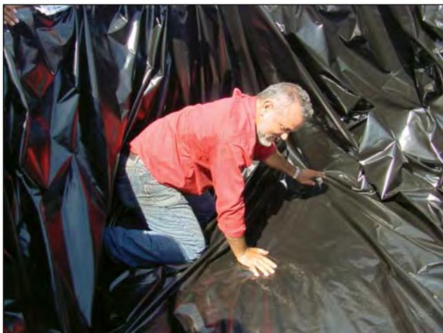
10. Sacar la manguera de desagüe a través del plástico y sujetarla con tripa de caucho.
