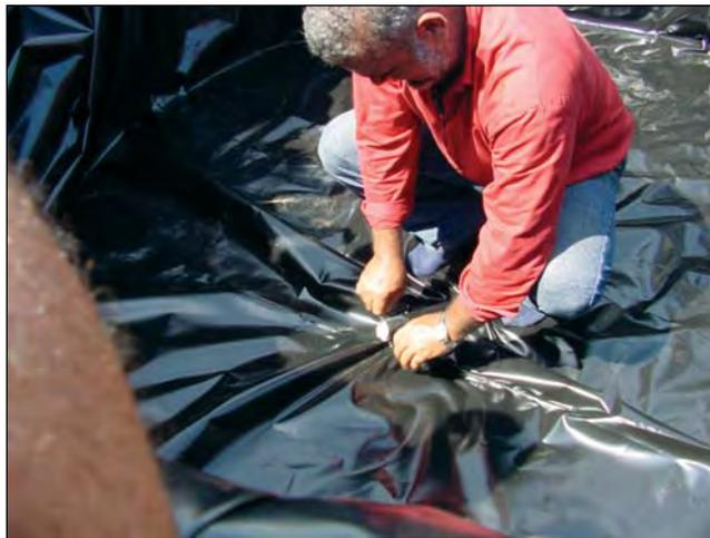
11. Amarrar el plástico al tanque con el mecate, por la parte externa del tanque.
