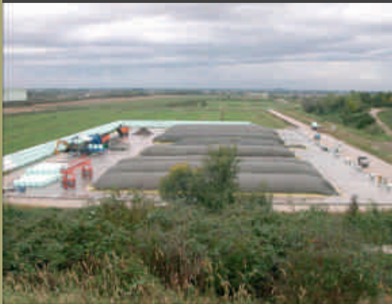
Ilustración 8.- Sistema pilas estáticas aireadas
